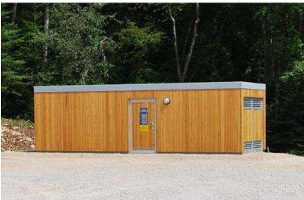
Un réseau de câbles enterrés relie les éoliennes entre elles, et mène le courant en 20 kV jusqu'à une **structure de livraison**. Ensuite, le câble chemine jusqu'à un poste source haute-tension pour être injecté sur le réseau public de transport d'électricité.
